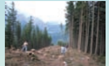
Die neuangelegte Schneise für die Tourengänger.
