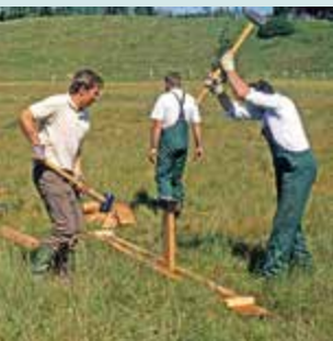
Errichtung von Dämmen im Moor.
